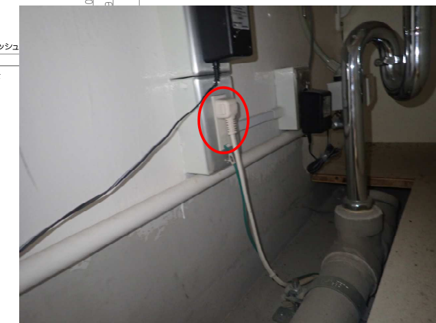
仮設電気使用コンセント (既設電気温水器用)
