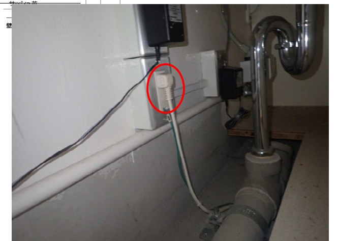
仮設電気使用コンセント(既設電気温水器用)
